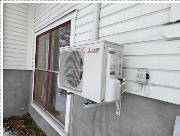
Bilde nr. 48 Varmepumpe, Mitsubishi
