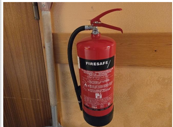
Bilde nr. 54 Håndslukker, vann med tilsetning
