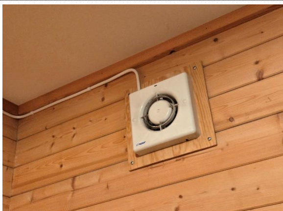
Bilde nr. 59 Flexit avtrekksvifter
