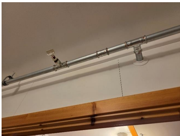
Bilde nr. 53 Rørsystem sprinkler
